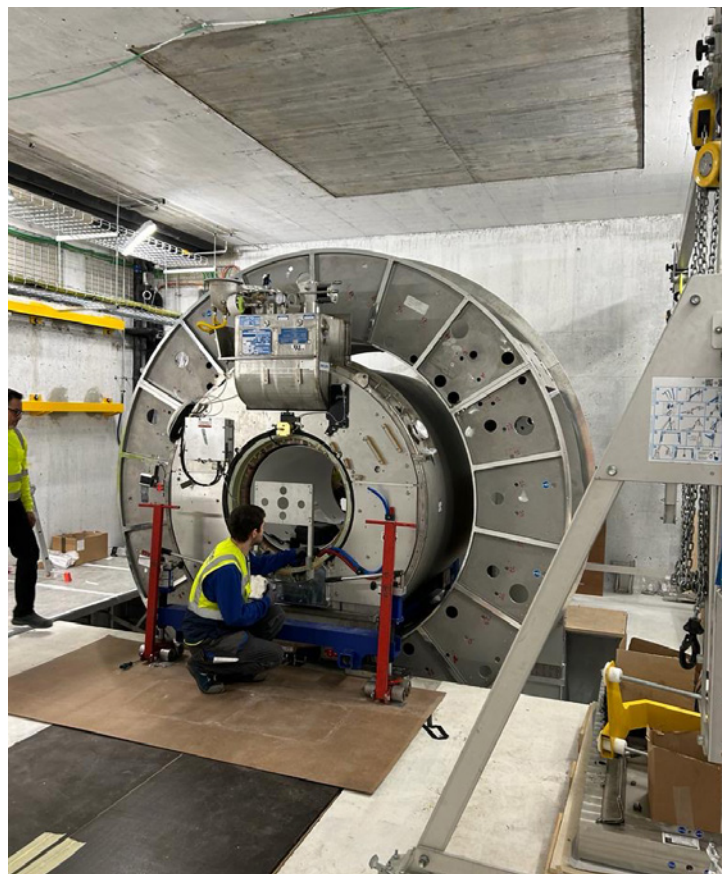
Bunker O.U. della Carità, Novara
