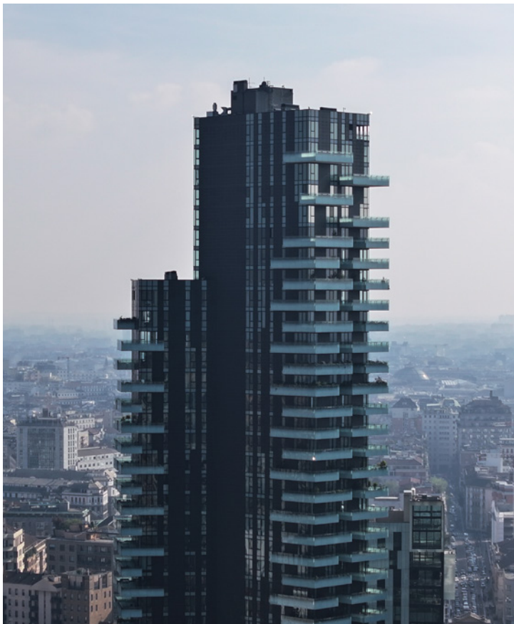
Torre Solaria, Milano
